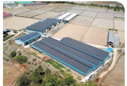
파란히늘 태양광발전소 702kW(강원 철원)
