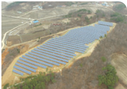
미르 태양광발전소 990kW (충남 홍성)
