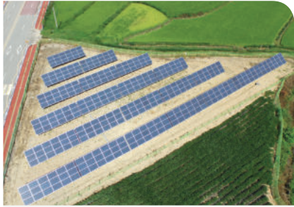
에코그린 태양광발전소 100kW (충남 청양)
