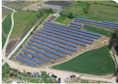
금빛 태양광발전소 450kW (충북 제천)
